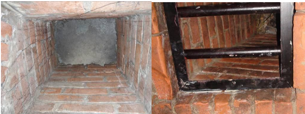
Figuur 41: Een luchtkoker met en zonder traliehek.
