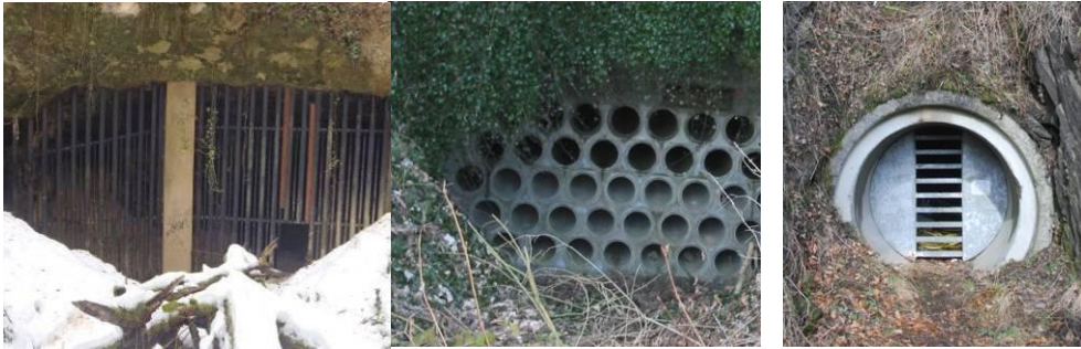
Figuur 40: Voorbeelden van 'vleermuisvriendelijke' afsluiting. Hierbij is de afmeting van de oorspronkelijke opening zo min mogelijk aangepast. Verder is voldoende luchtstroming langs grond en plafond mogelijk.
