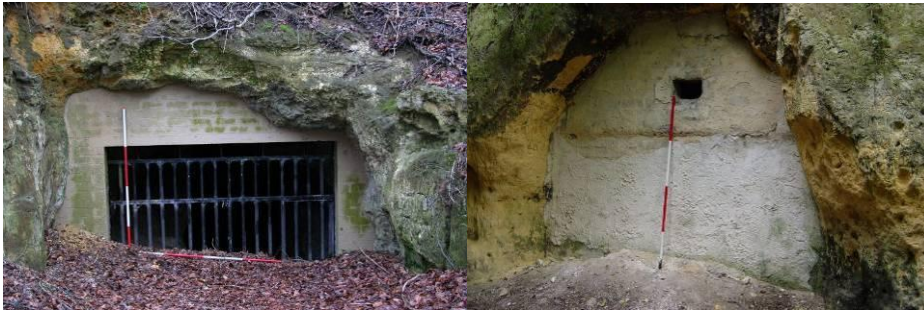
Figuur 37: Het verkleinen van een invliegopening. Deze openingen zijn kleiner dan de oorspronkelijk opening, waardoor ook de hoeveelheid luchtcirculatie zal verminderen.
