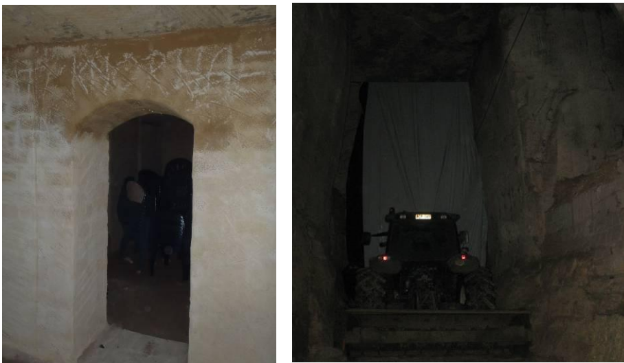
Figuur 38: Het maken van een tunnel of versmalling. De oorspronkelijke gang is hier verlaagd (links) of de doorgang is belemmert door middel van landbouw plastic.
