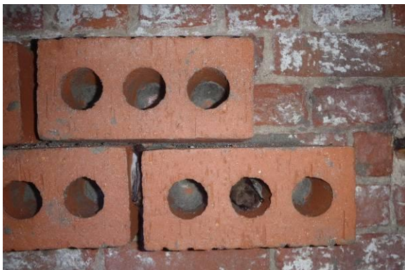
Figuur 44: Holle bakstenen in gebruik door vlemuizen. De gebruikte bakstenen zijn van een Belgisch type, 'Boerkens65' (18x8,5x6,5) te koop bij de Brico in België. Op deze foto is te zien dat vlemuizen ook gebruik maken van de ruimtes tussen de onderlinge bakstenen.
